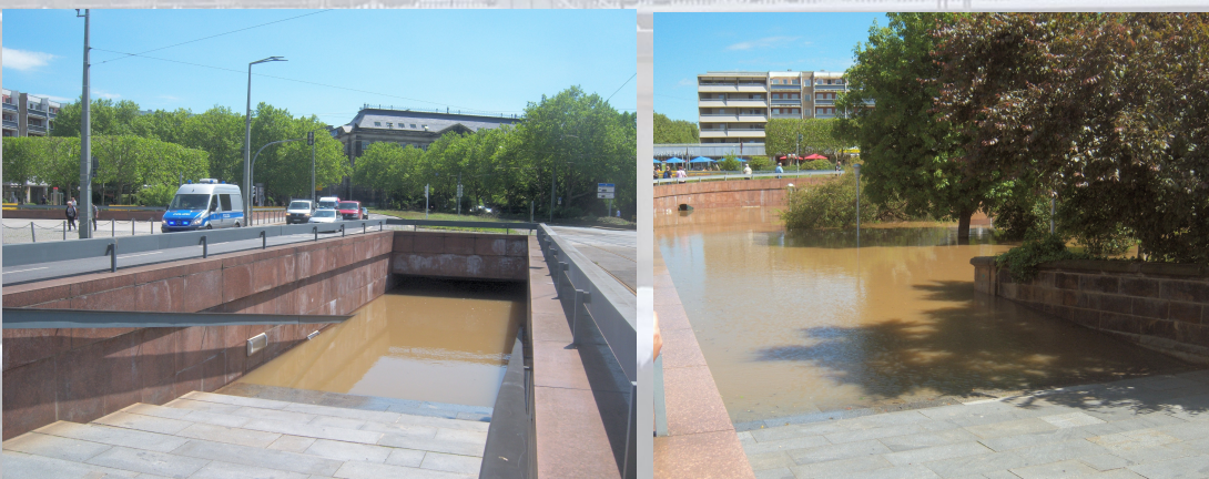
Hochwasser im Neustädter Fußgängertunnel im Jahre 2013 (Fotos: Torsten Kulke, Dresden)
