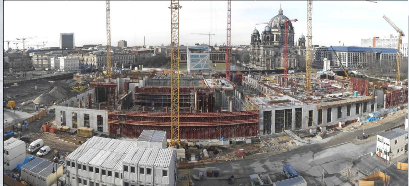
Aktueller Blick auf die Baustelle des Stadtschlosses/Humboldtforums
